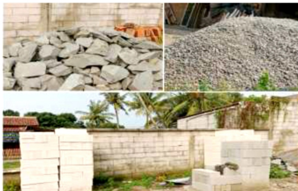
Material yang sudah ada
